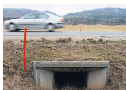
Sinnlos: Zu diesem Krötentunnel führt kein Leitsystem – weshalb er seinen Zweck nicht erfüllt. Die vielen überfahrenen Kröten sind vom starken Regen in den gestrigen Morgenstunden weggespült worden. BILD: HON
